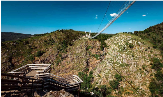
Passerelle et ponton de Paiva
