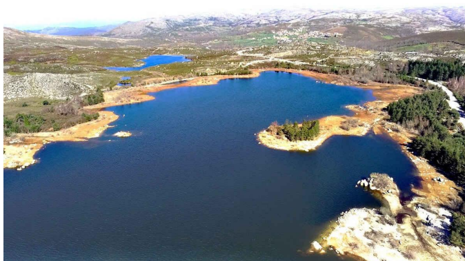
Barragem Cimeira do Alvão
