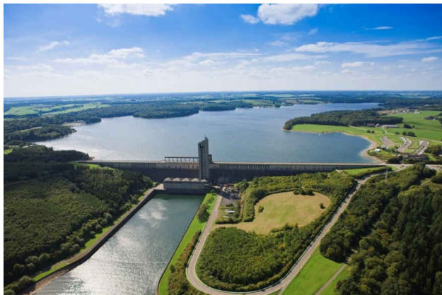
Barrage de l'Eau d'Heure
